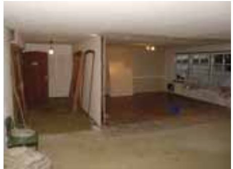
Umbauarbeiten, Wettfahrleiterbüro und Vorstandszimmer
